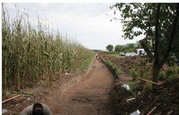
1. Pogled na izkopan del trase za kablovod na Ižišču v Ivancih.
