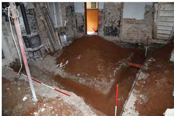
Pogled na testne jarke v notranjosti pritličnega prostora, Izola, Kopaljska ulica (foto: A. Ogorelec).
