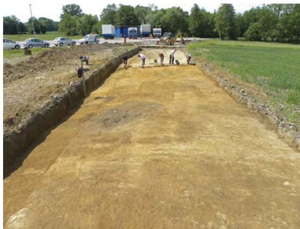
Pogled na izkopno polje.
