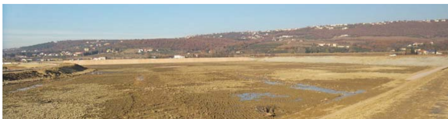
Ankaran, Bonifika: območje kasete po končanem izkopu ter postavitvi nasipov.
