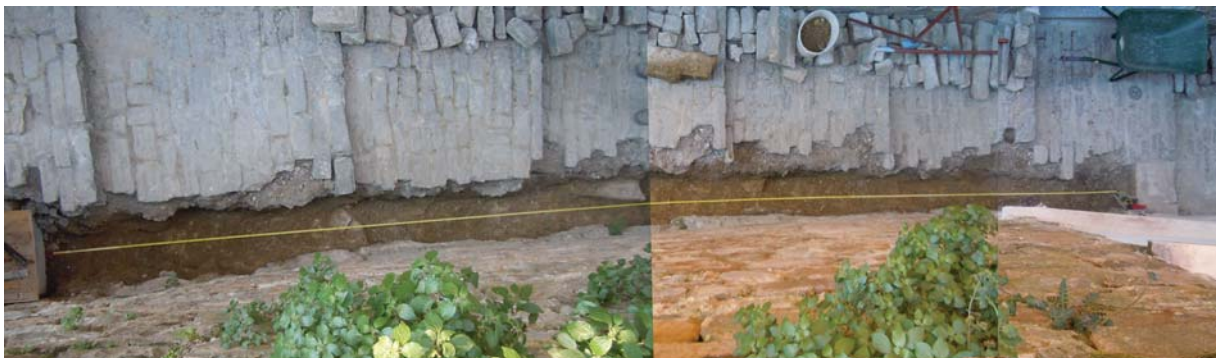
Gortanova 25, 6330 Piran, pogled na izkopen jašek.
